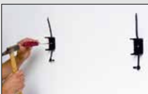
Se recomienda la instalación de las abrazaderas cada 50 cm.
