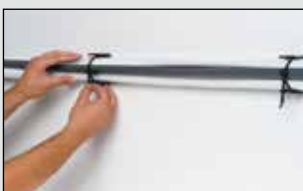
Se recomienda la instalación de las abrazaderas cada 50 cm.
